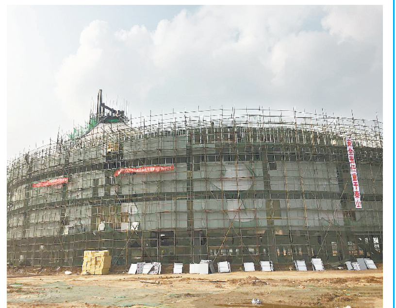
建设中的淮阳县体育馆。
