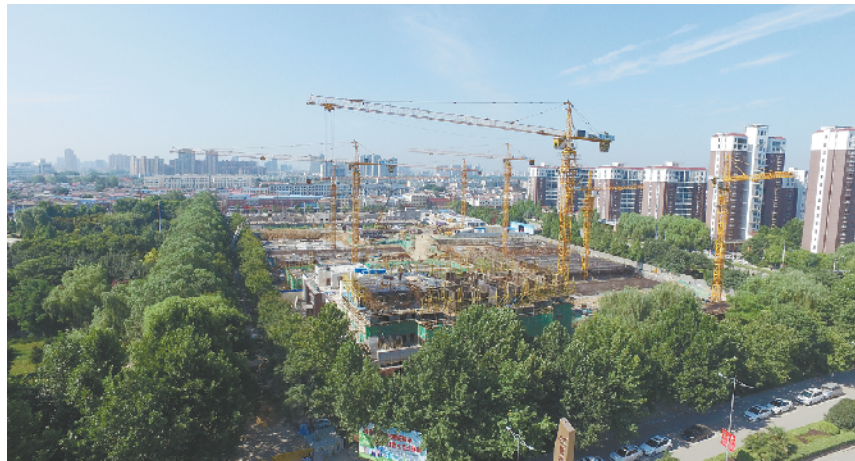
川汇区碧桂园城市之光项目位于川汇路与健康路交叉口,由碧玺置业有限公司投资兴建,总建筑面积106016.093平方米,投入使用后将有效提升沙北城市品位。图为施工现场。②7 记者 韩志刚 通讯员 理效明 摄
