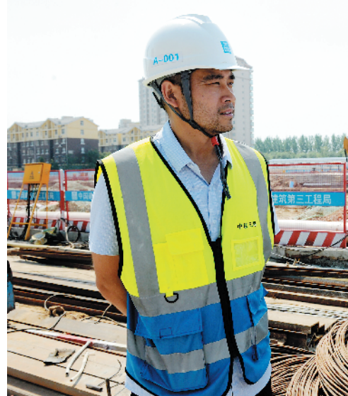
王剑到工地检查工程质量。
