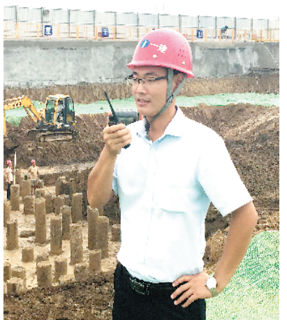
朱艳锋在施工现场安排工作。
