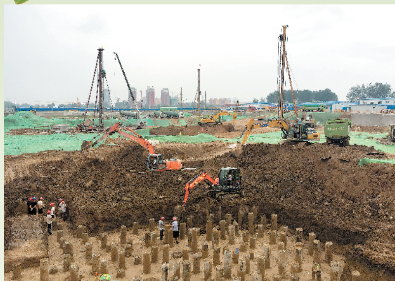
施工现场机器轰鸣,工人师傅利用有利天气条件抓质量赶进度
