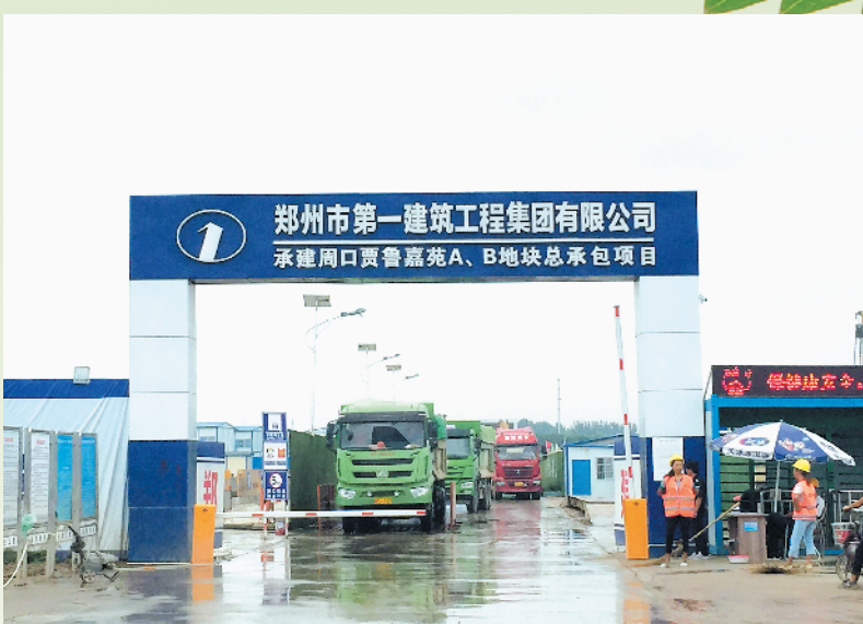
安全高效的标准化工地
