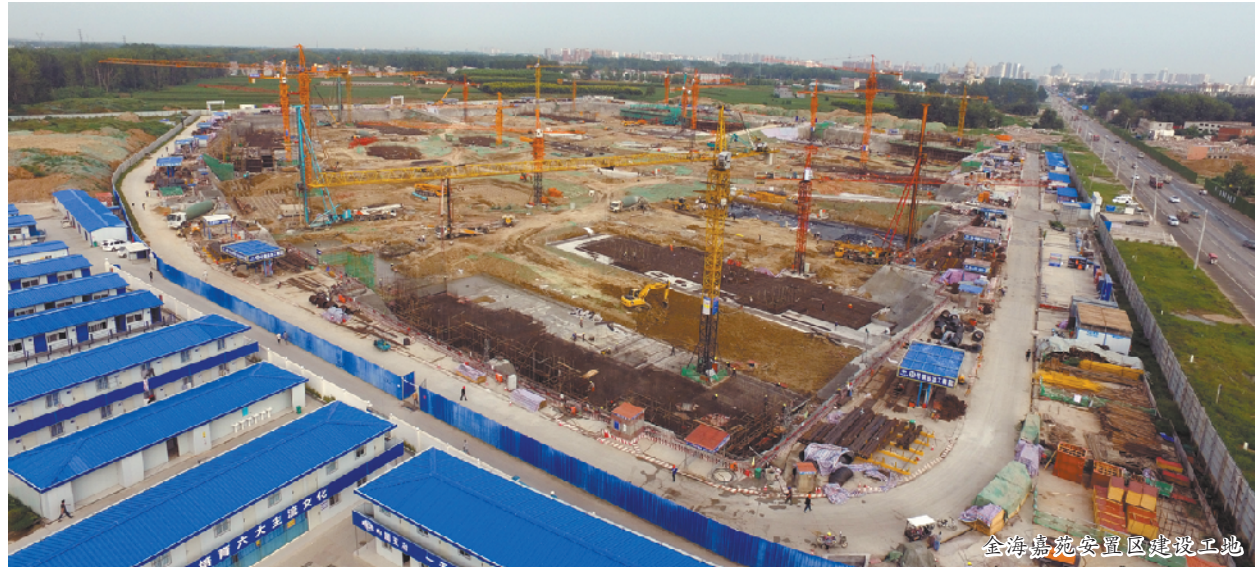
新北环建设现场
