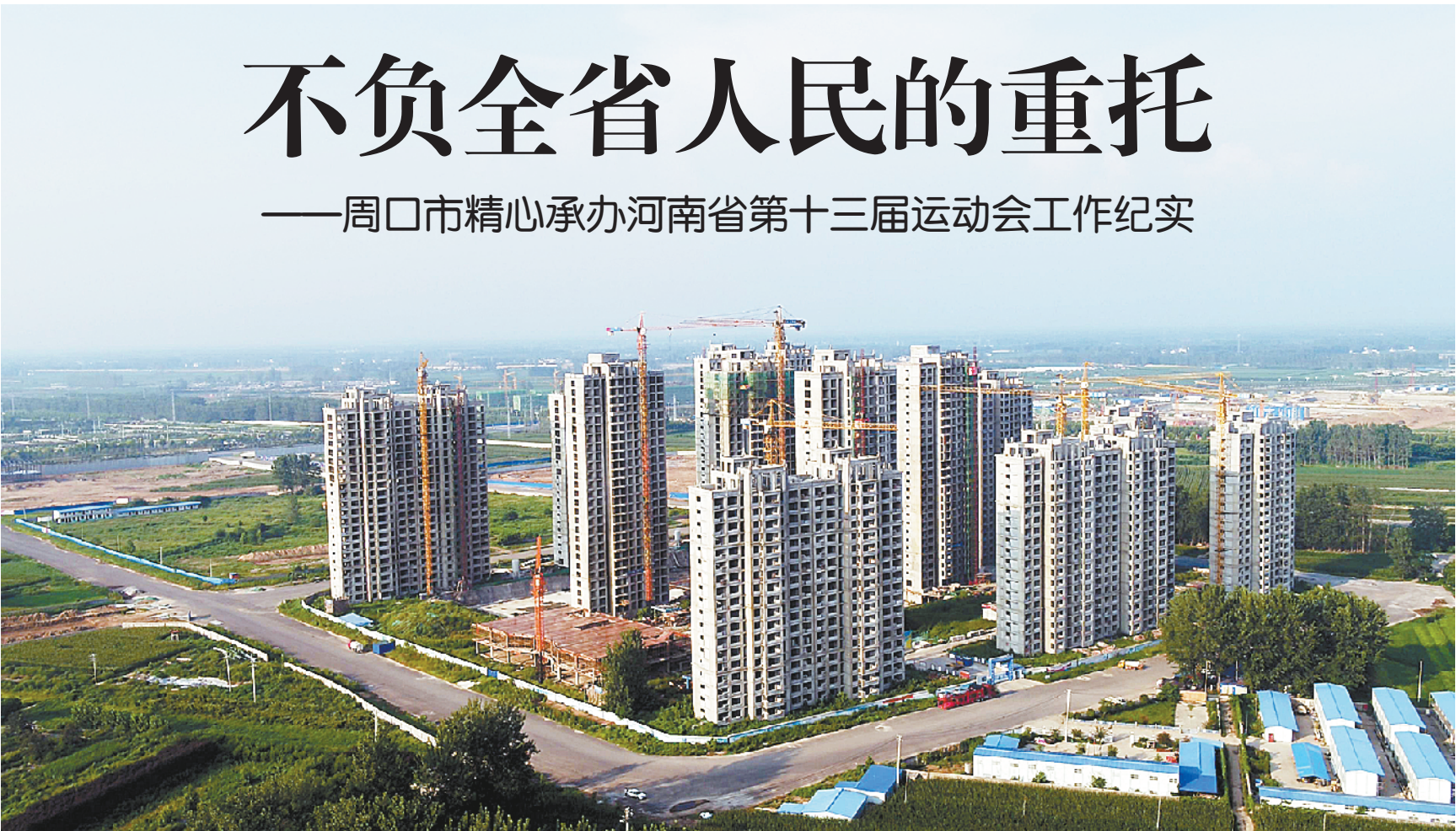
丰和家园安置区建设现场
