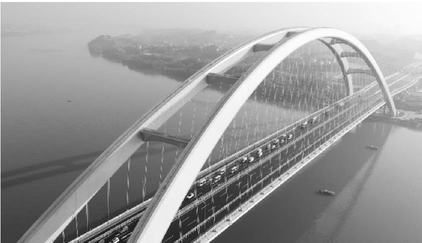
广西柳州官塘大桥建成通车 11 月 27 日, 参加通车仪式的车辆通过广西柳州官塘大桥 (无人机拍摄)。当日, 广西柳州官塘大桥建成通车。柳州官塘大桥横跨柳江, 水中不设桥墩, 跨度达 457 米, 整桥主线全长 1155.5 米, 桥面由 148 根吊索与上方的两条拱座相连。
