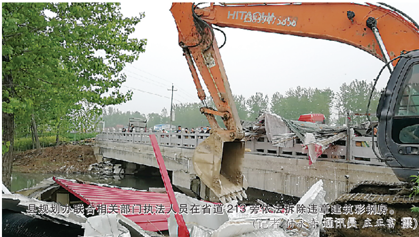
县规划办联合相关部门执法人员在省道213旁依法拆除违建建筑彩钢房。(记者 付永奇 通讯员 庄正富 摄)
