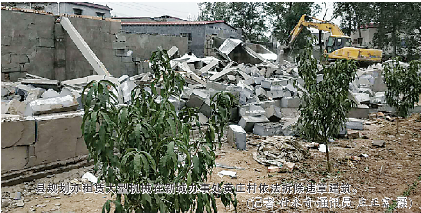
县规划办租赁大型机械在新城办事处黄庄村依法拆除违建建筑。(记者 付永奇 通讯员 庄正富 摄)
