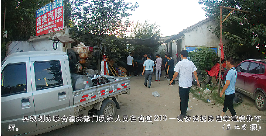
县规划办联合相关部门执法人员在省道213一侧依法拆除违建建筑修车店。(庄正富 摄)
