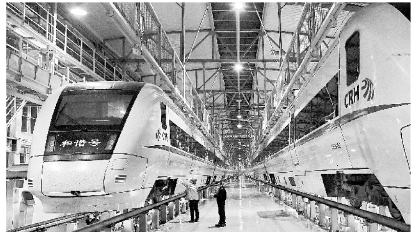
夜战保安全 2月14日晚,工作人员在福州动车所检修动车。春运以来,福建省近3000名高铁动车维护人员日夜坚守岗位,通宵达旦对181组高铁动车进行全面检查维护,确保每辆高铁动车安全上线,平稳运行。新华社记者 张国俊 摄
