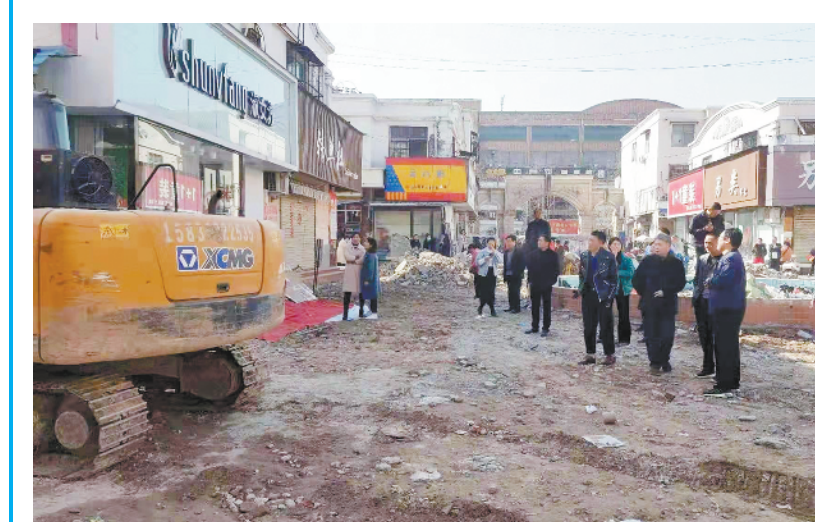
3月14日上午,太康县城关镇政府联合县城管执法局对德银商城院内房外房、房外棚、房外梯及消防通道上的“两违”建筑进行了集中拆除。图为拆除现场。 记者 马治卫 通讯员 张永俊 摄
