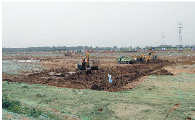
昨日上午,沈丘航运枢纽项目建设工地现场,一派火热施工景象。据了解,改建沈丘航运枢纽,是沙颍河周口至省界航道升级改造的重要组成部分。沈丘航运枢纽项目建设,目前正在进行基坑土方开挖、防渗帷幕、降水井等工程施工。记者张艳丽摄
