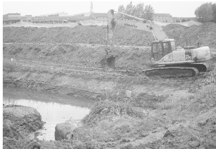
在农村人居环境整治专项行动中,魏集镇以农村垃圾清运、污水治理和村容村貌改善为主攻方向,加大对农村坑塘的治理力度,彻底改善了群众的生活环境。图为7月19日,该镇组织人员、机械清理河道垃圾。
