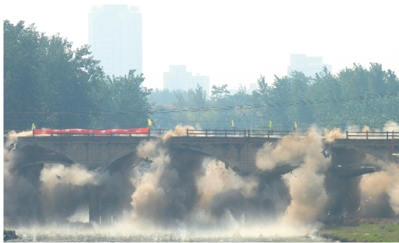
2008年9月,周口贾鲁河桥爆破。
