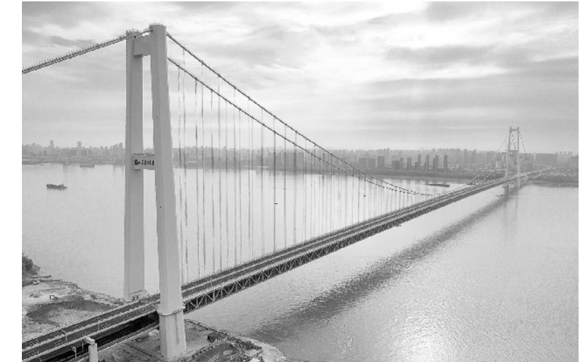
长江上首座双层公路大桥通车 武汉杨泗港长江大桥(9月25日无人机拍摄)。10月8日,长江上首座双层公路大桥——武汉杨泗港长江大桥正式投入使用。杨泗港长江大桥全长4.13公里,主跨1700米,一跨过长江。大桥上层为城市快速路,双向6车道,设计行车时速80公里;下层为城市主干道,双向6车道,设计行车时速60公里。
