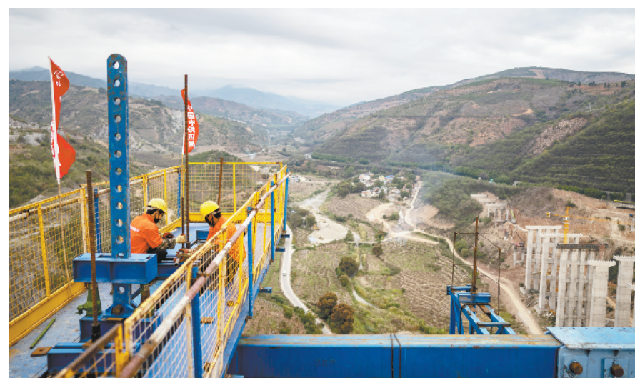
中老铁路有序复工 3月5日,工人在中老铁路南溪河特大桥上施工。近期,中老铁路玉溪至磨憨段有序复工复产,由中铁四局承建的中老铁路全线重点控制性工程——元江特大桥、南溪河特大桥正在加紧施工建设。 新华社记者 江文耀 摄
