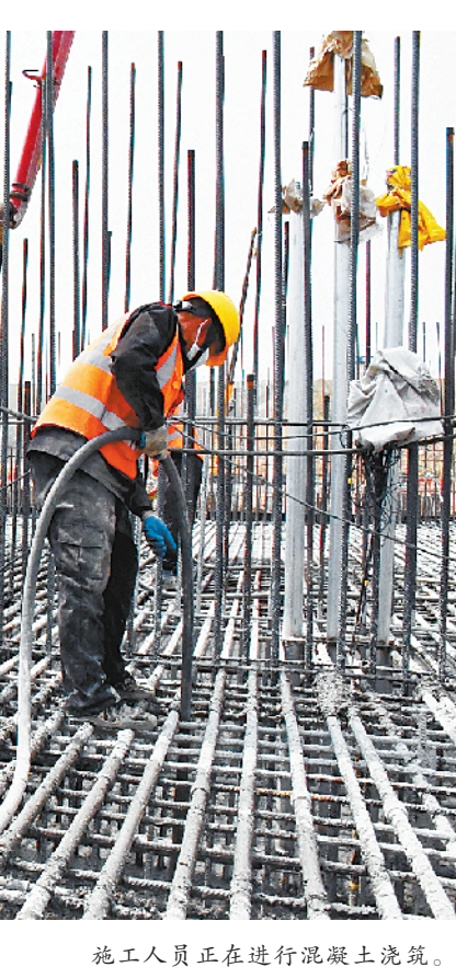
施工人员正在进行混凝土浇筑。
