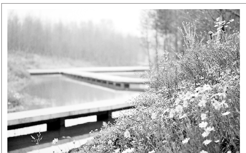
近日,位于周口市城乡一体化示范区的引黄调蓄工程迎来今年第一次蓄水,蓄水后的湖面更加广阔,一片烟波浩渺,湖边覆盖着绿树花草,宛如江南水乡小景,格外美丽。 记者 梁照曾 摄
