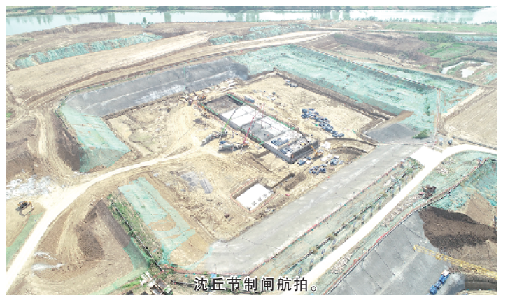
沈丘节制闸航拍。
