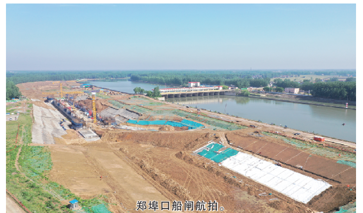
郑埠口船闸航拍。
