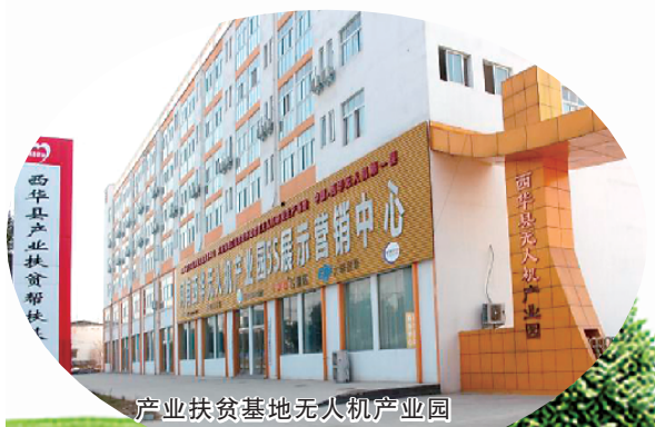
产业扶贫基地无人机产业园
