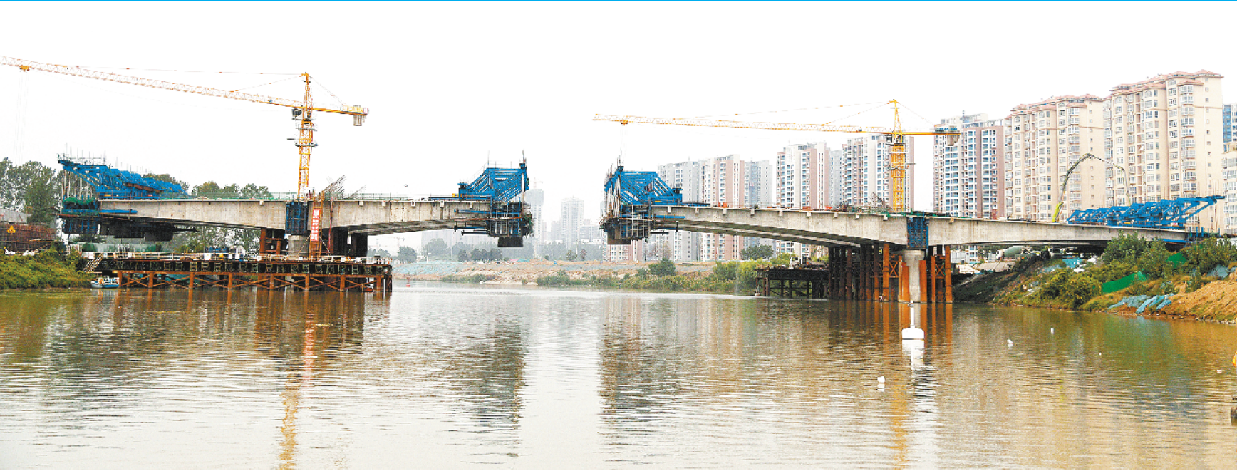
昨天，记者在中原路跨沙颍河桥施工现场看到，中原路跨沙颍河桥即将合龙。目前，桥体剩下两段桥体未建成，分别是跨河南桥墩两侧的桥体，预计需要一个月时间。周口市中原路跨沙颍河桥梁及道路打通工程项目全长 2.686 公里。其中，中原路跨沙颍河桥主桥采用下承式多索面拱梁组合桥，拱肋在桥面以上分离成两片拱肋，分别通过拉索与主梁和人行道挑壁连接，两片拱肋通过拱间拉杆连成整体，远看像一轮新月，展现“明月罩古城”的美景。
