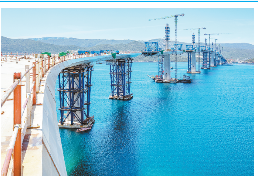
中企承建克罗地亚佩列沙茨跨海大桥项目施工稳步推进
