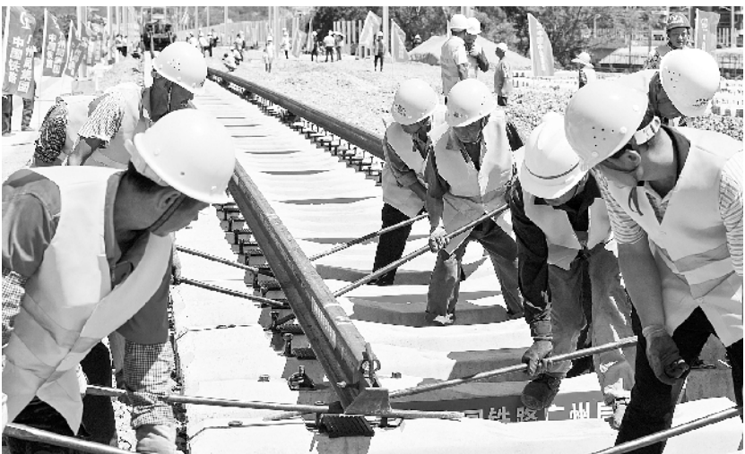
赣深高铁广东段铺轨至深圳北站
