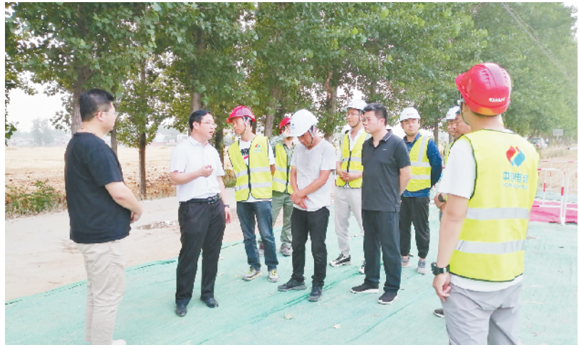
商水县平店乡高度重视安全生产工作,经常开展安全隐患排查和整改工作。图为6月17日该乡干部在风电清洁能源40MW分散式风电项目现场进行安全检查。记者 付永奇 通讯员 赵永昌 摄
