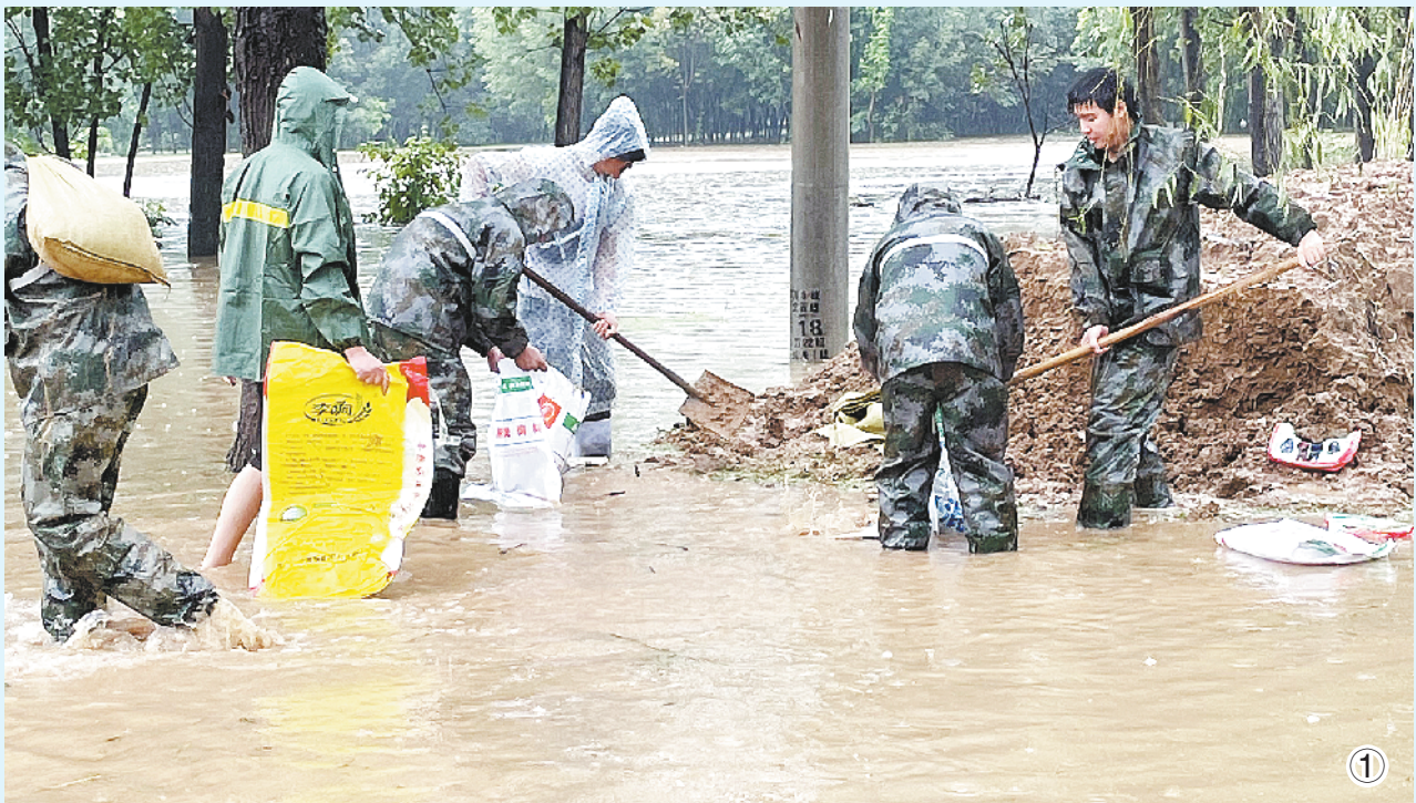
图一 连日来,扶沟县广大党员干部始终冲锋在第一线、战斗在最前沿,把防汛抗洪作为当前首要政治任务,迅速贯彻落实上级决策部署,采取多种措施,最大限度减少灾害损失。图为党员干部正在加固堤防。 记者 金月全 摄
