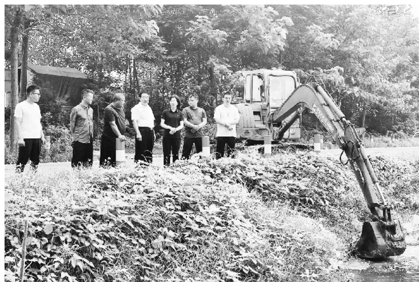
郸城县石槽镇上下同欲,合力奋战,调动大型挖掘机31辆、抽水机225台,挖沟通渠、内疏外排,积极开展防汛生产自救,最大程度减少汛情造成的损失。图为7月22日,该镇班子成员一线指挥防汛排涝。 记者 卢好亮 通讯员 刘慧慧 摄
