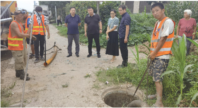
7 月下旬以来的汛情导致西华经开区内雨水管网系统不同程度损坏。汛情过后，该区迅速调集近百辆清淤车辆，加班加点对辖区雨污管网进行清淤修缮。
