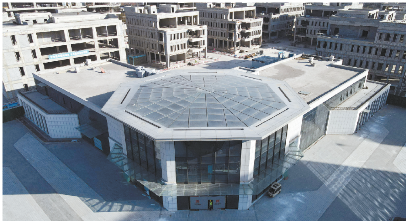
在建项目施工现场
