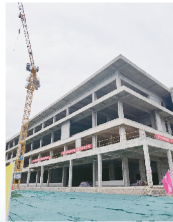
鹿邑县“双创”孵化园建设项目
