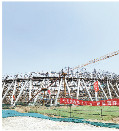
周口钢铁焦化配套项目
