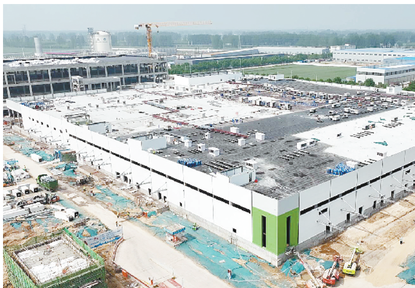
建设中的益海嘉里项目
