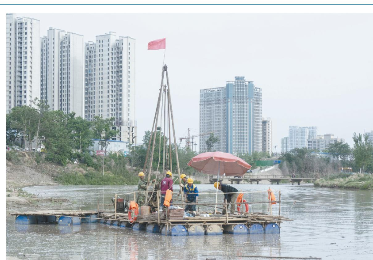
5月15日下午,施工人员在贾鲁河内开展河床地质勘探,以了解土层状况,为未来的文昌大道跨贾鲁河大桥(新二板桥)施工做准备。文昌大道跨贾鲁河大桥是我市的重点规划项目,也是文昌大道西延的重要组成部分,于近年纳入城市建设规划中。记者 梁照曾 摄
