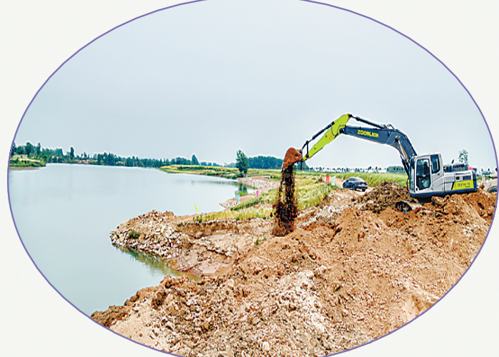
沙河尚湾水毁险工护岸治理
