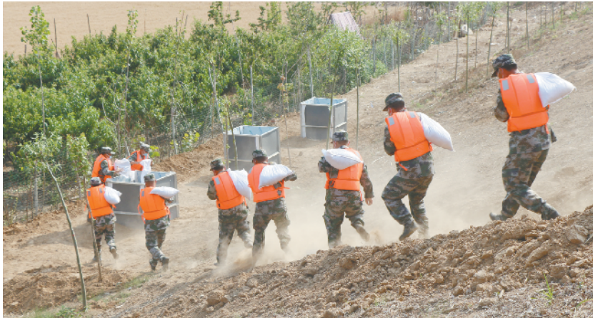
现场模拟河堤出现管涌,抢险队员采取行动对管涌洞口进行沙石填塞。
