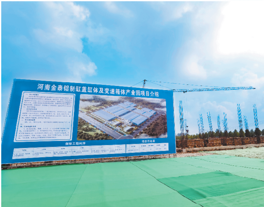
金泰铝制缸缸体及变速箱壳产业园
