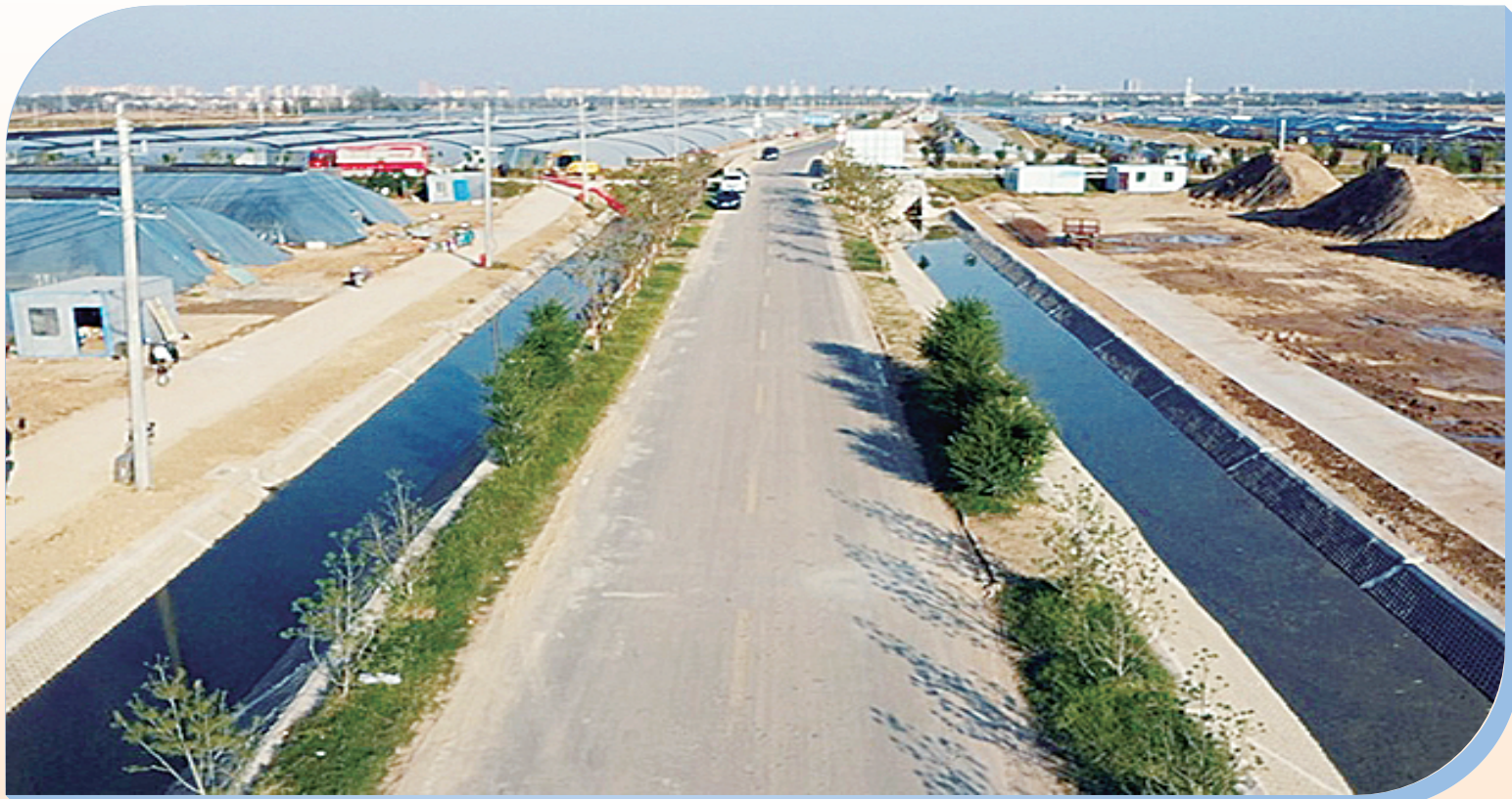
近日,在扶沟县蔬菜园区,蔬菜路两侧16公里长的引水渠建成后,该县水利局组织力量向渠内注水,为蔬菜“解渴”。放眼望去,崭新的水渠里水流潺潺,成为一道美丽的乡村风景线。 张力友 王永杰 摄
