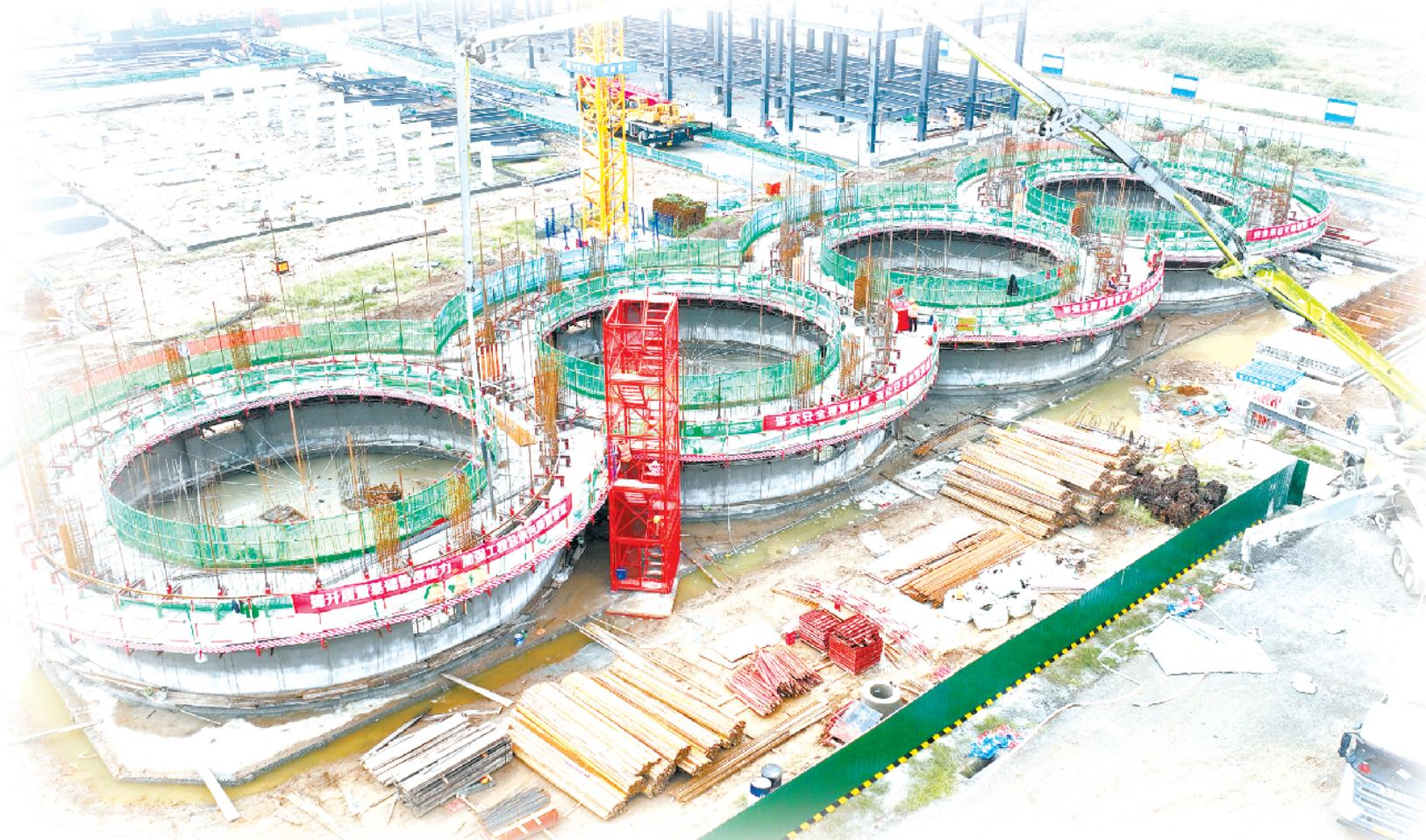
本报讯（记者 宋风 通讯员 赵磊 文/图）10月20日23时，由中建二局承建的益海嘉里（周口）现代食品产业园年加工140万吨大豆项目迎来重要工程节点，四连体散粕筒仓仓壁滑模施工全部完成（如图），为项目如期完工奠定了坚实基础。
