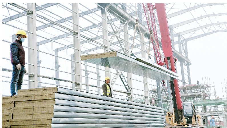
图为项城市豪鑫金属回收废旧蓄电池综合利用项目施工现场。
