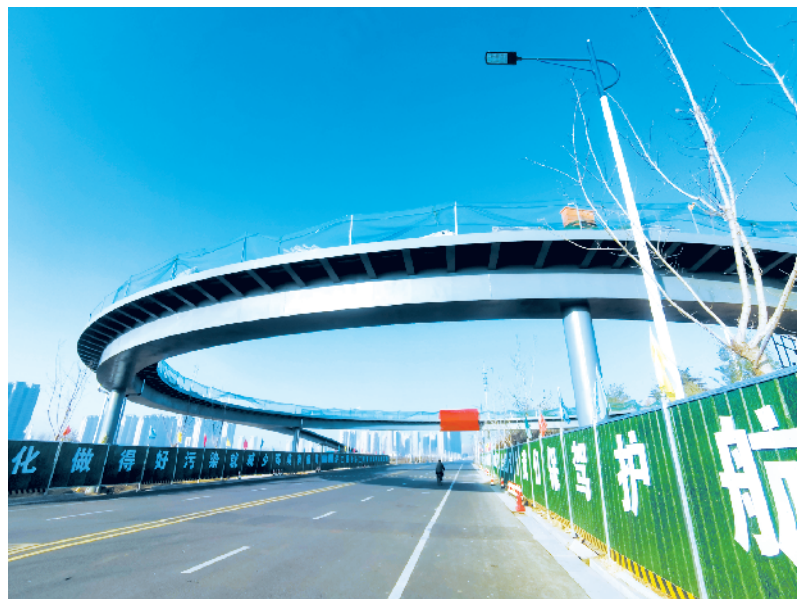
建设中的滨河南路人行天桥
