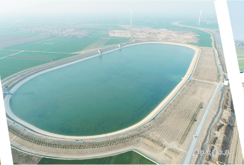
鹿邑后陈陈楼加压泵站
