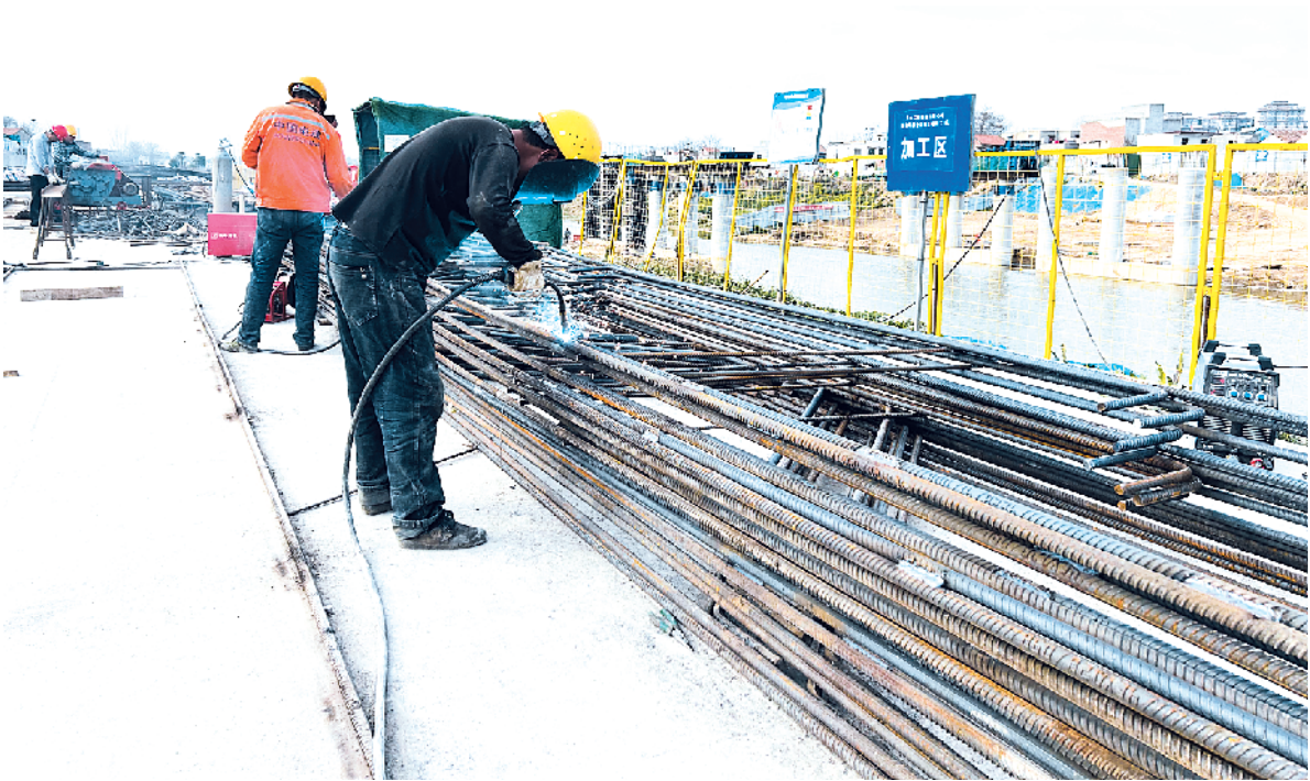
贾鲁河二板交通桥项目施工现场,工人们正在紧张施工。
