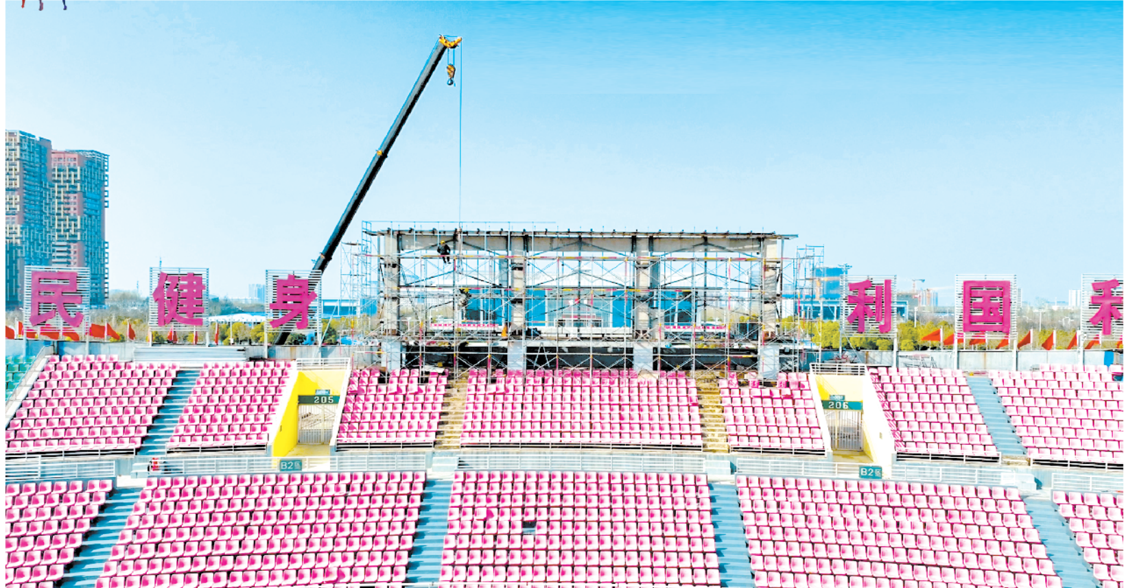
3月27日，在周口市体育中心，工人正在指挥吊机安装更换体育场内的LED屏幕，安装完成后将用于现场直播第九届全省民族运动会表演项目。记者 戚勇 摄
