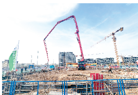
广东民赞实业有限公司新能源线缆束产业园项目
