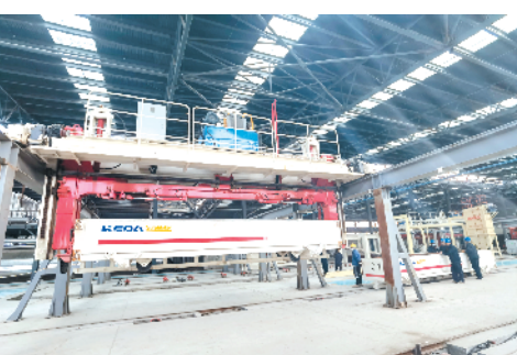
商水县兴源建材有限公司粉煤灰砖生产线项目
