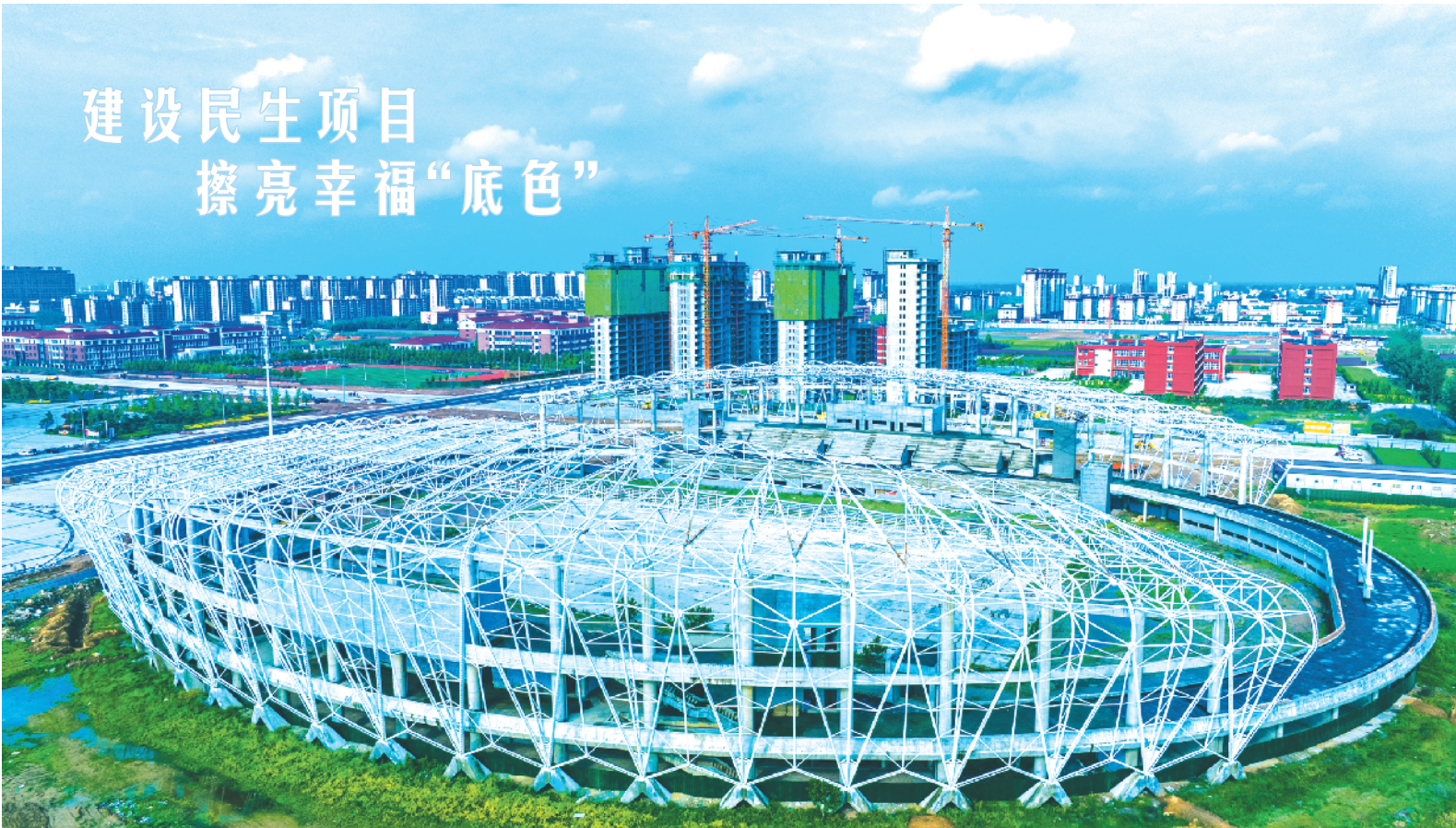
今年以来,扶沟县不断完善民生配套设施,明确民生项目攻坚目标任务,突出解决好群众“急难愁盼”问题,抓实工程建设,压实各方责任,紧盯进度、质量、安全,多措并举实施民生项目建设,让更多的建设成果惠及于民,实实在在增强人民群众的获得感、幸福感、安全感。图为建设中的扶沟县体育中心项目。
