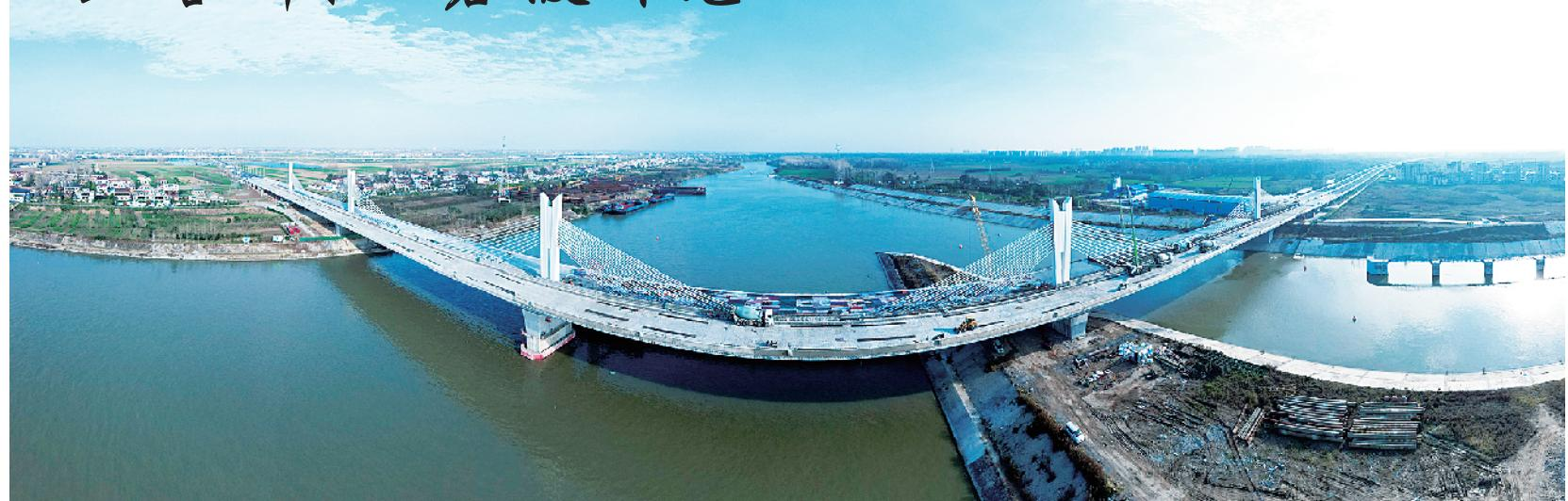
11月13日下午，G106淮阳刘楼至项城李庄段沙颍河大桥工程施工现场，工人们正在有序作业。该工程于2020年开工建设，大桥全长5公里、宽34米，设计标准为双向六车道，主桥部分为五塔斜拉结构，施工工艺先进，施工难度大。
