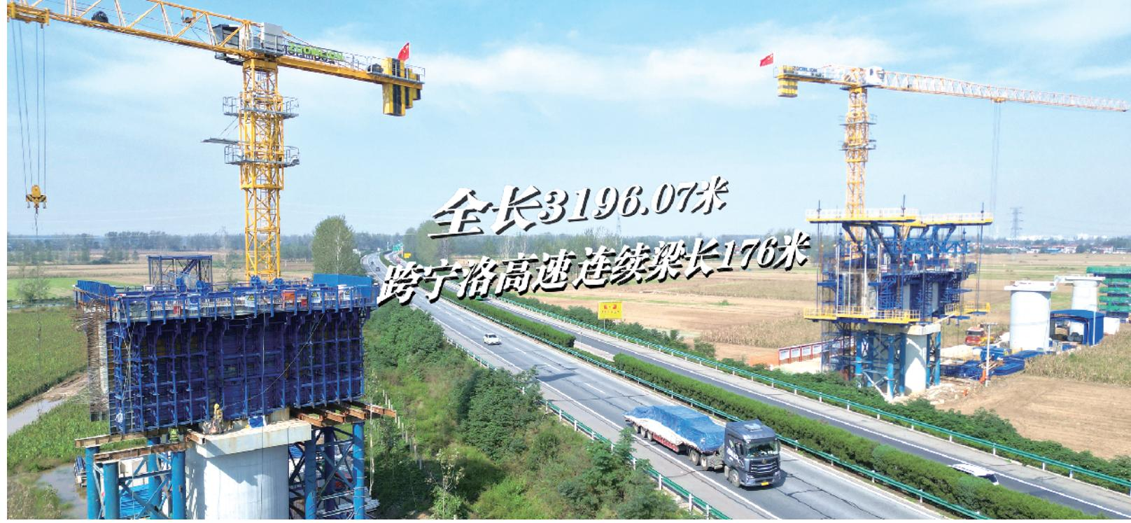
10月22日,在周口中心港集疏运铁路专用线跨宁洛高速特大桥施工现场,工人正加紧作业。据悉,周口中心港集疏运铁路专用线全长12.663公里,总投资16.33亿元,于2025年4月15日开工,建设工期2年。其中,工程难度最大的跨宁洛高速段为特大桥工程,全长3196.07米,共设计桩基445根、墩台101处,跨宁洛高速连续梁长176米。目前,特大桥已完成桩基430根、桥墩61个,整体工程计划于2026年7月竣工。
