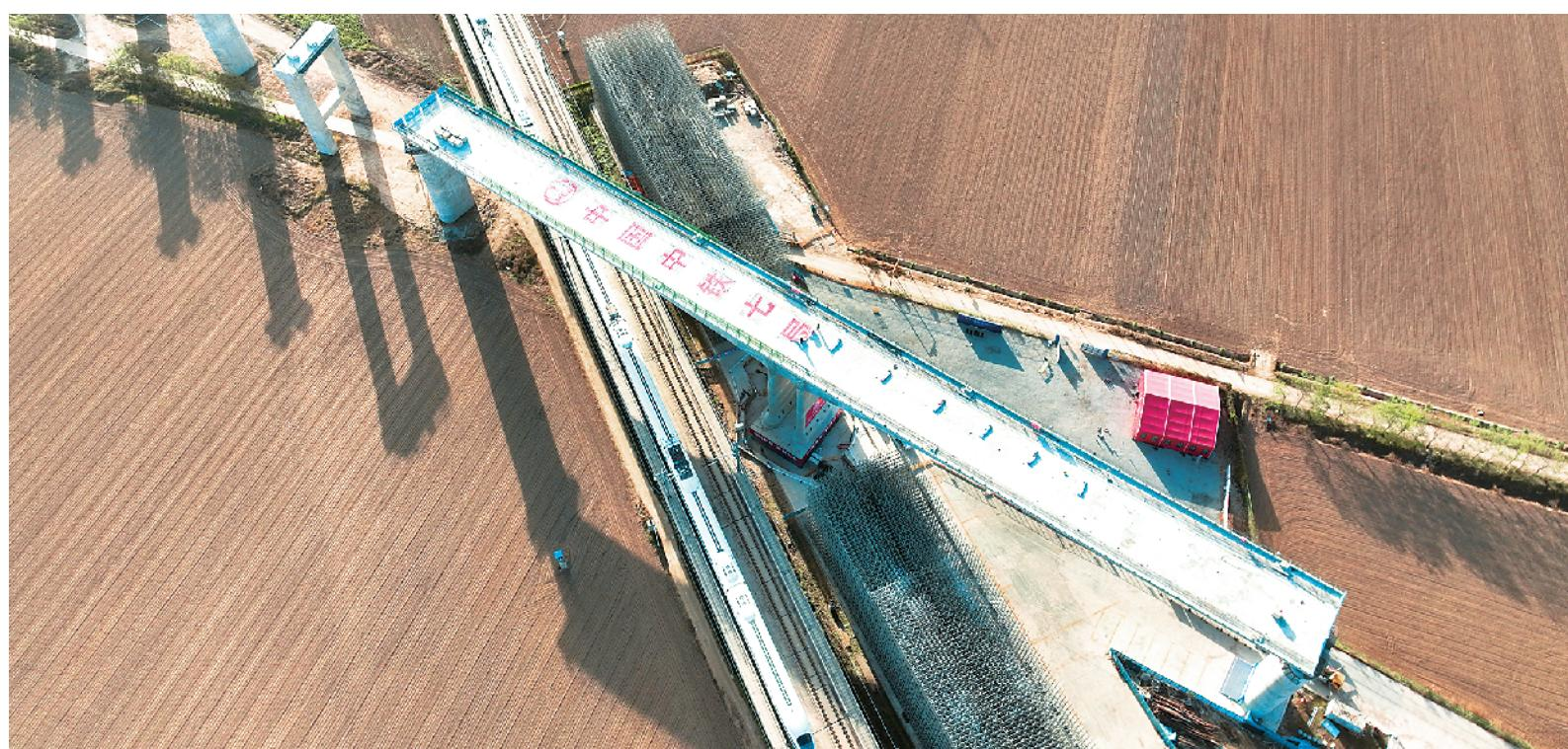
11月25日凌晨2时30分,平深周高铁商周特大桥关键桥梁结构历经140分钟精准操控完美实现空中转体,标志着该高铁全线首个跨越正在运营高铁线路的转体工程顺利完成。据悉,商周特大桥是目前河南省内首个采用“无边跨”设计的转体桥,其关键桥段全长161.5米、重量约9925吨。图为一高速列车从大桥下平稳驶过。
