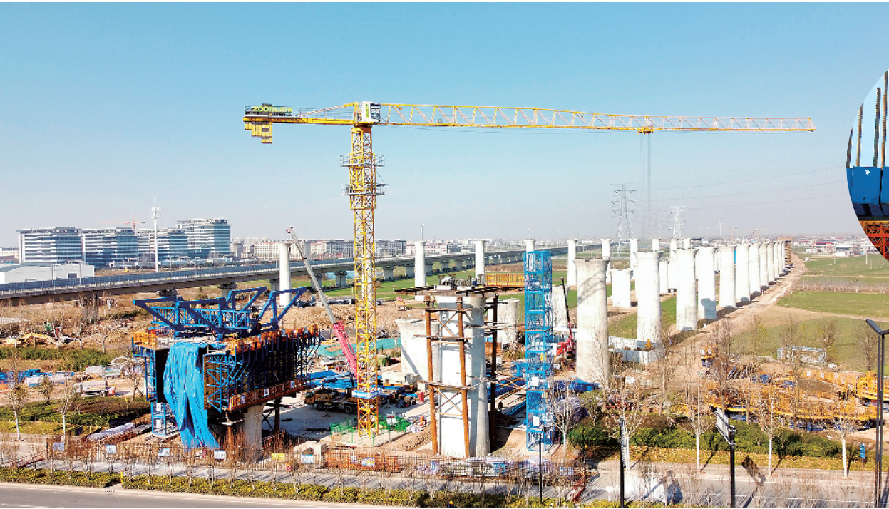
1 月 8 日，平周周高铁周口段跨太清路工程现场施工正酣。塔吊林立间，工人们坚守岗位、紧张作业，钢筋绑扎、桥梁架设等工序有序推进，钢铁长龙在城市上空逐渐形成。 记者 刘俊涛 摄
