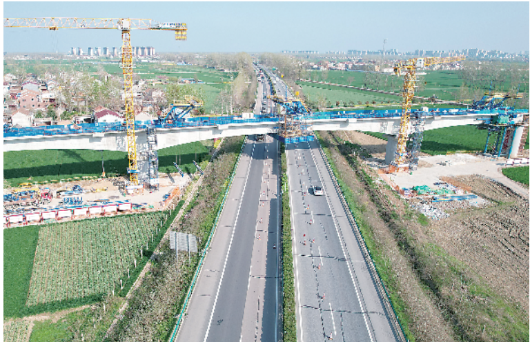
周口港中心港区集疏运铁路专用线项目正加快推进。
