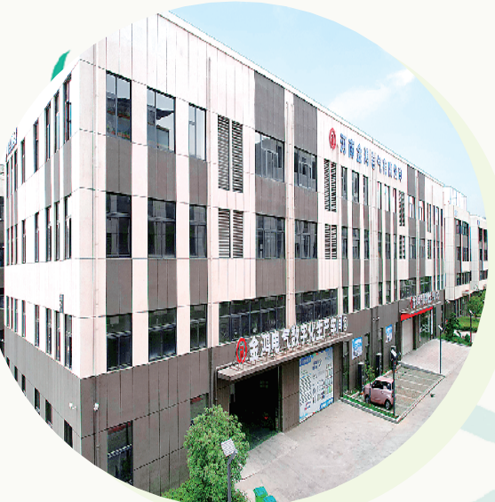
金鸿电气数字化生产车间。
