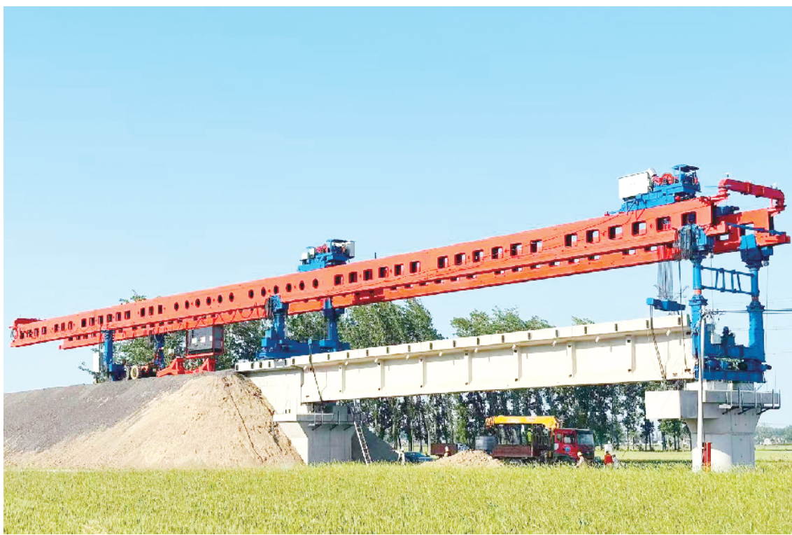
图为首片架梁现场。
